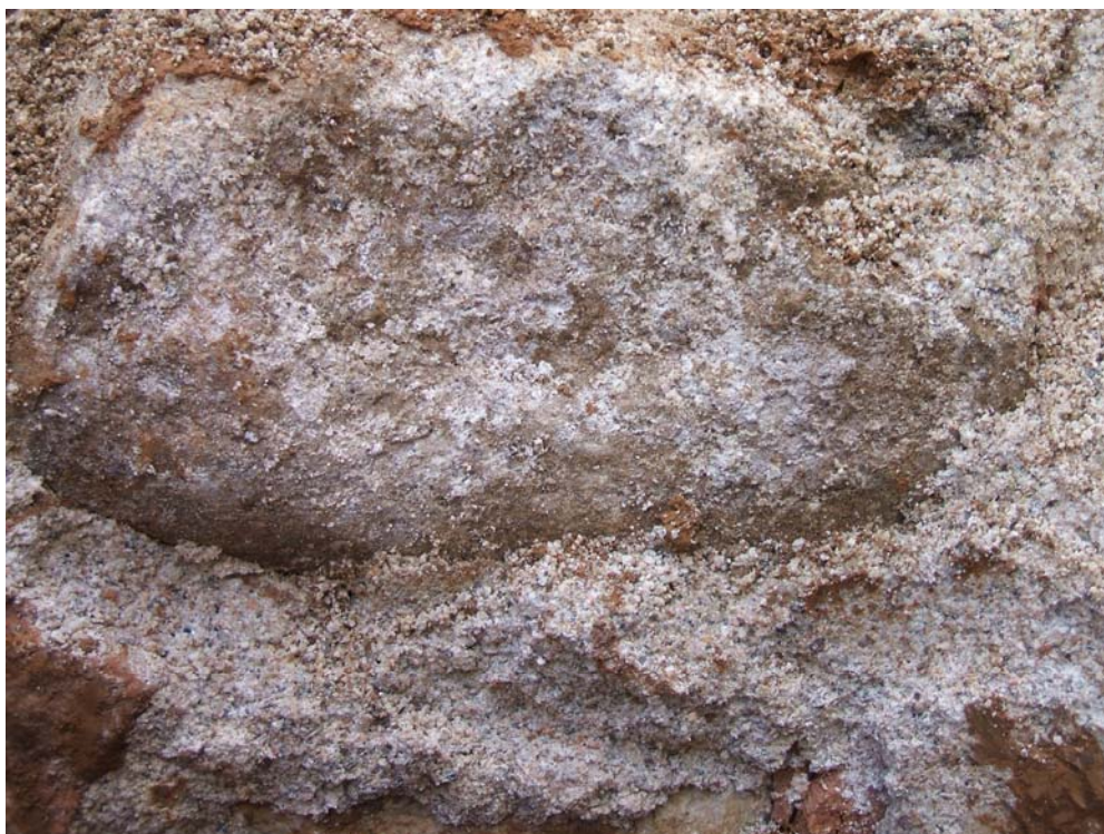
Fotografia 4: Material constructiu de les UE 106, 108 i 110, amb pedres molt irregulars i morter de calç blanquinós.
