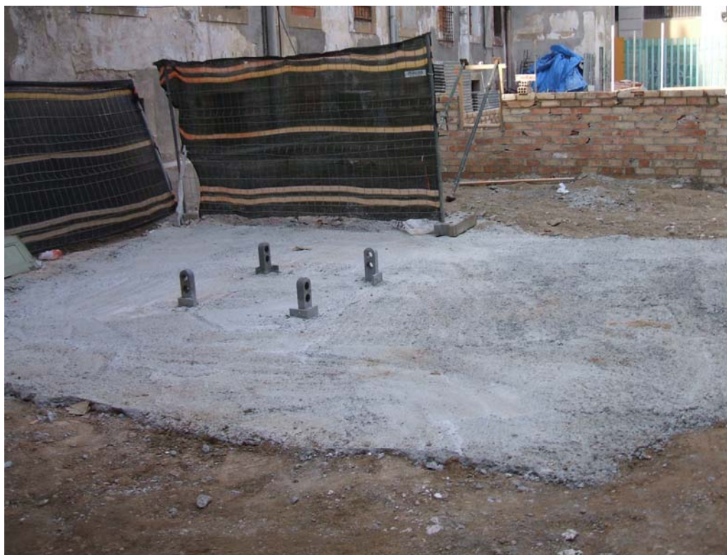
Fotografia 8: Vista general de la cata una vegada reomplida de formigó.
