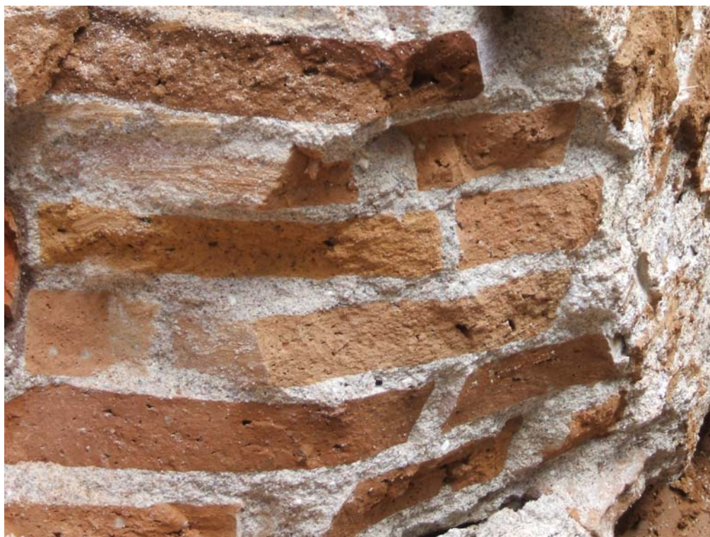
Fotografia 2: Construcció amb maons de l'UE 104.
